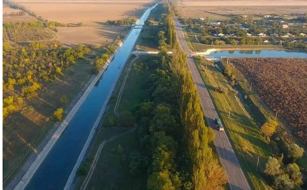
Рисунок 2.2 – Северо-Крымский канал в районе с. Новоивановка Нижнегорского района [8]
